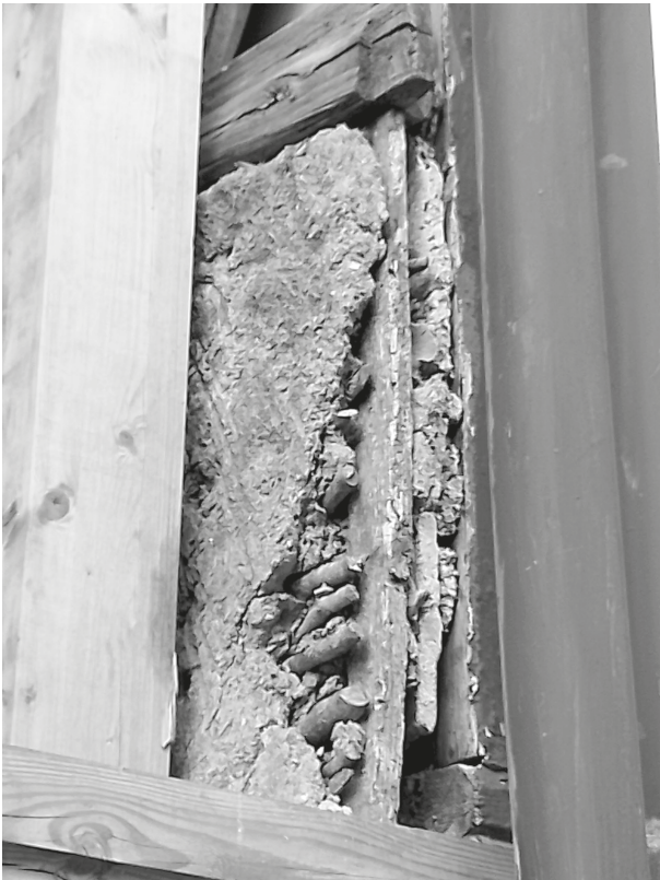
Gefach mit Lehm- und Strohverputz
